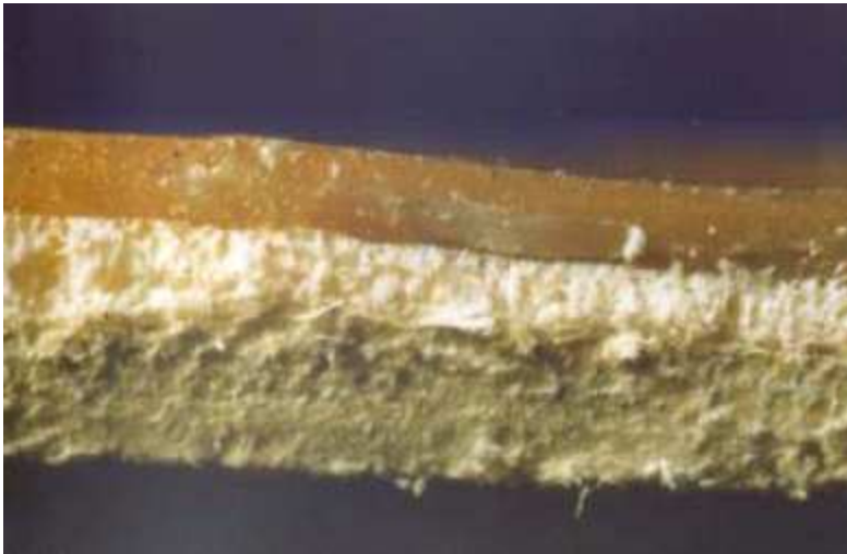
Coupe transversale d'un revêtement de sol à trois couches dont la couche inférieure est composée d'un carton d'amiante
