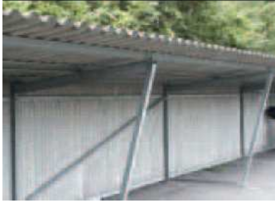
Toiture ondulée en fibrociment
