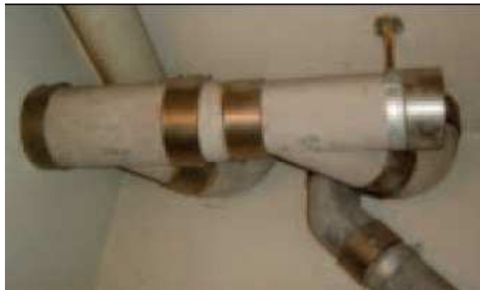
Conduite en amiante ciment recouverte de peinture ou de bitume
