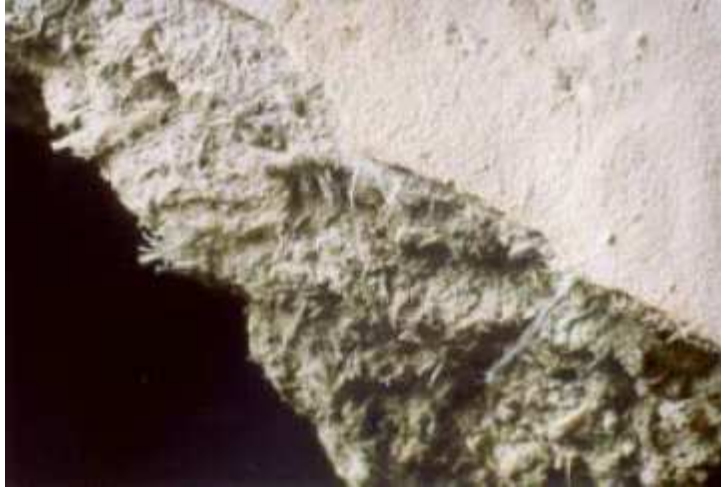
Plaque de fibrociment avec des faisceaux de fibres
