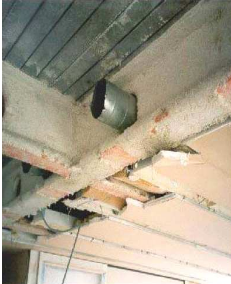
Flocage d'une structure métallique
