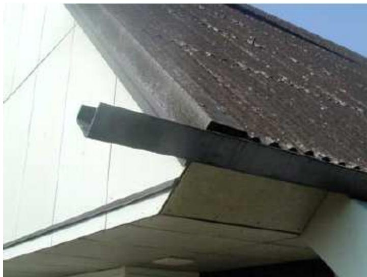
Toiture ondulée en fibrociment
