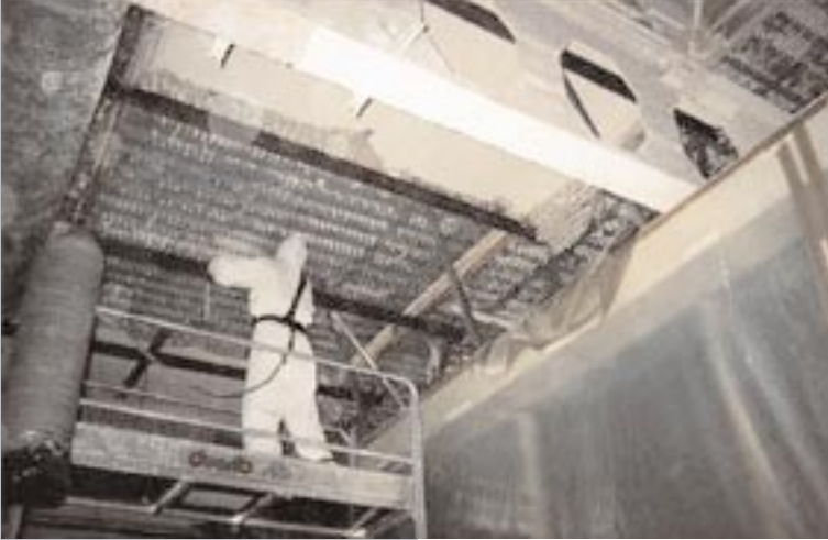
Grattage manuel d'un flocage sous aspersion d'un produit mouillant.
