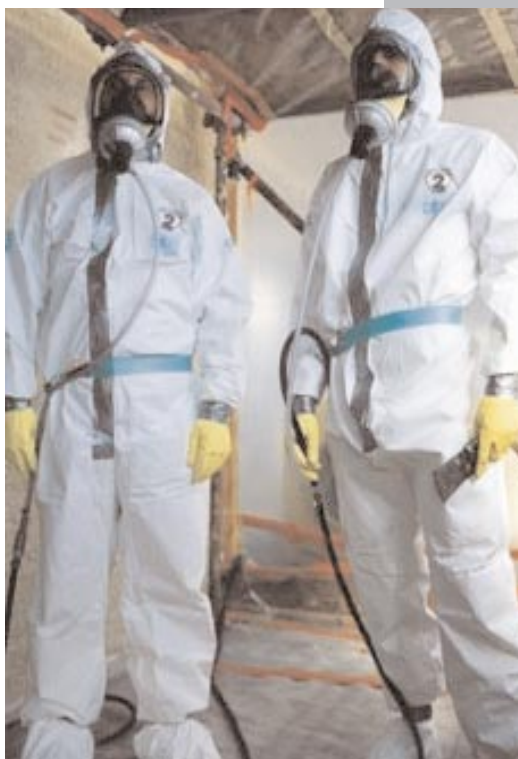
Masques complets à adduction d'air comprimé (avec filtres P3 en série). Les tuyaux doivent rester fixés à la ceinture pour éviter l'arrachage du masque (photo AFPA).
