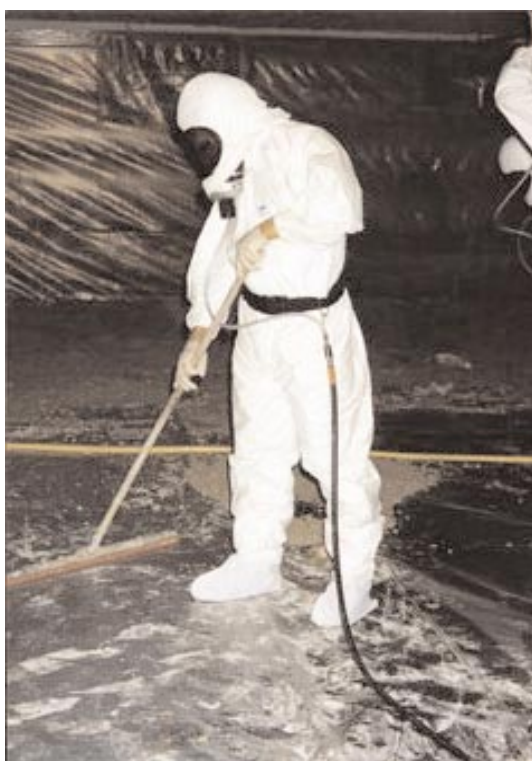
Combinaison étanche jetable avec capuche adaptée au contour du masque à adduction d'air comprimé. Les brides du masque sont toujours placées sous la capuche.
