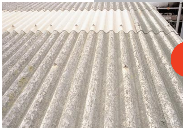
Toiture en amiante-ciment.
