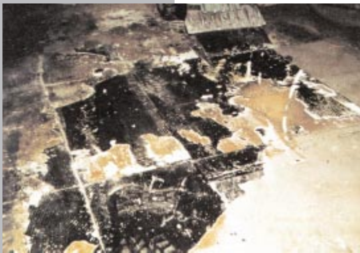
Décollement des dalles à la machine par réchauffage (photo CRAM Nancy).
