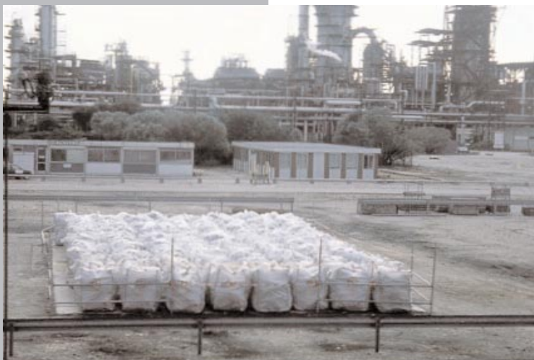
Stockage intermédiaire de déchets en GRV dans une zone surveillée.
