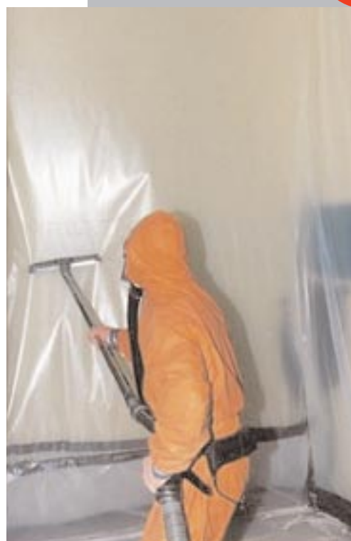
Les films du déconfinement sont dépoussiérés avec soin avant leur démontage.
