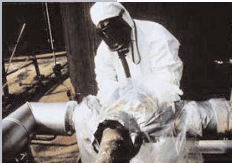
Intervention en extérieur sur une bride à trois voies, à l'aide d'un sac à gants.
