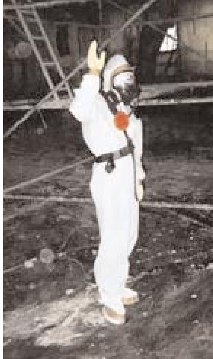
Masque complet à ventilation assistée et filtre TMP3 fixé sur le masque.
