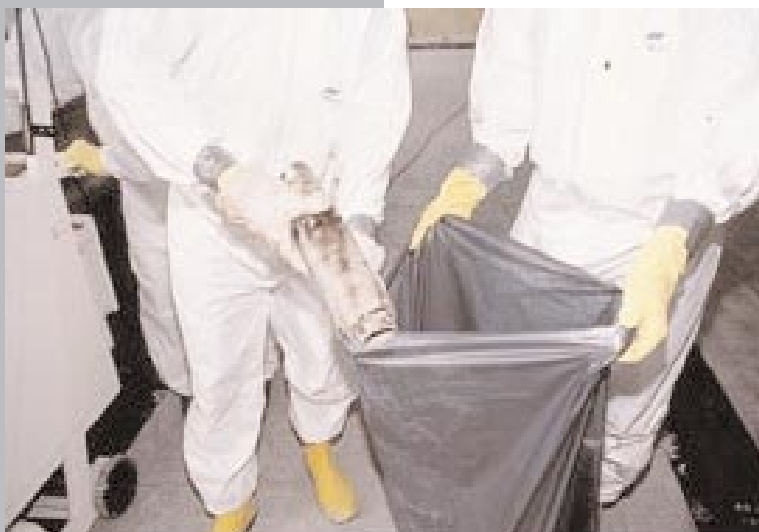
Mise en sac de déchets de revêtements de sols.
