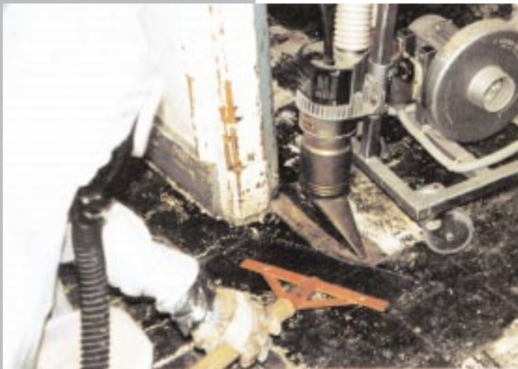
Décollement des dalles à la machine par réchauffage (photo CRAM Nancy).
